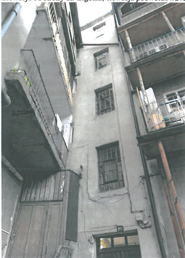
Fot. 3 Elewacja podwórzowa budynku mieszkalnego
