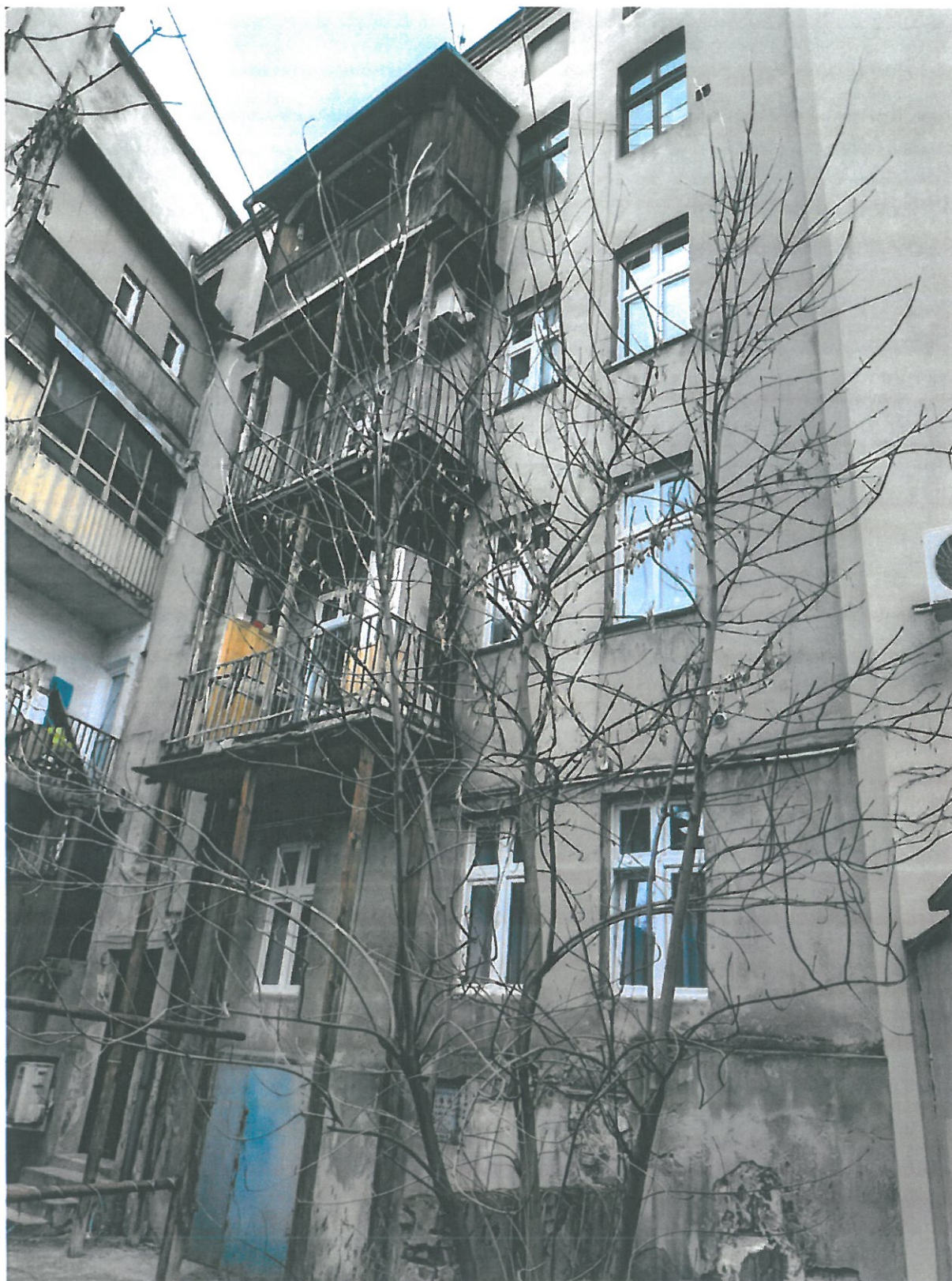
Fot. 5 Elewacja podwórzowa budynku mieszkalnego
