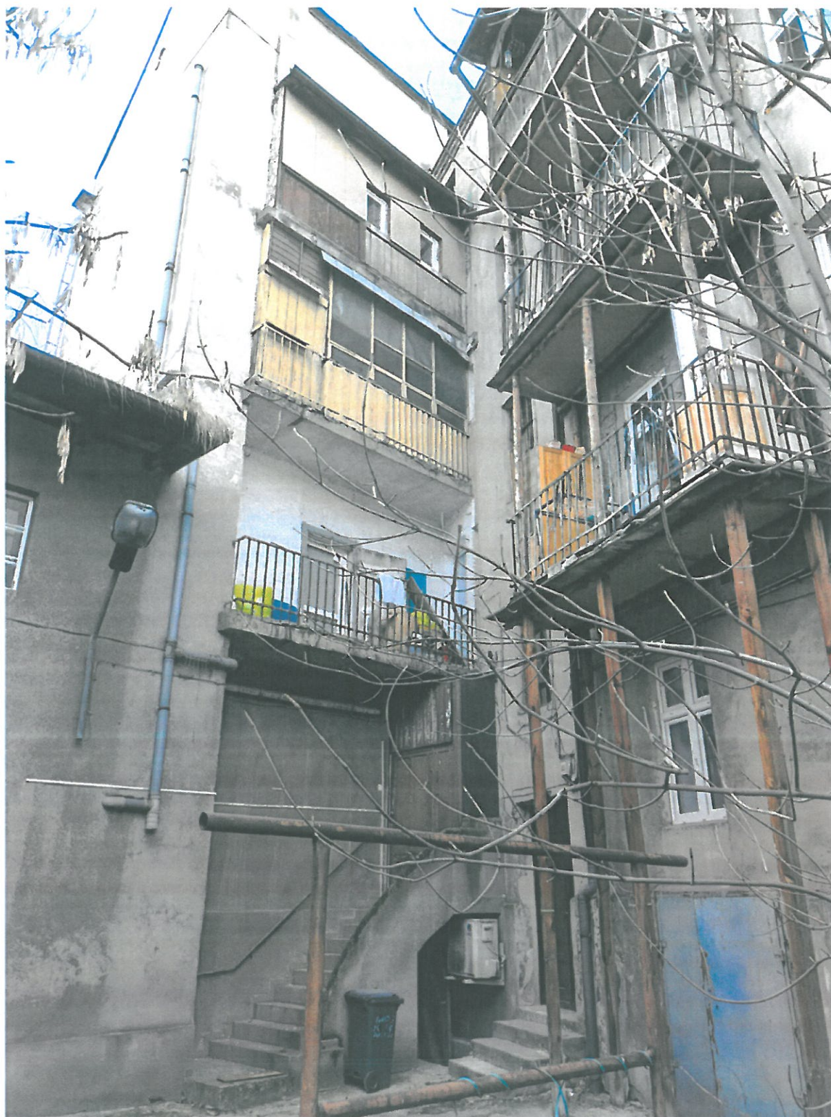
Fot. 4 Elewacja podwórzowa budynku mieszkalnego
