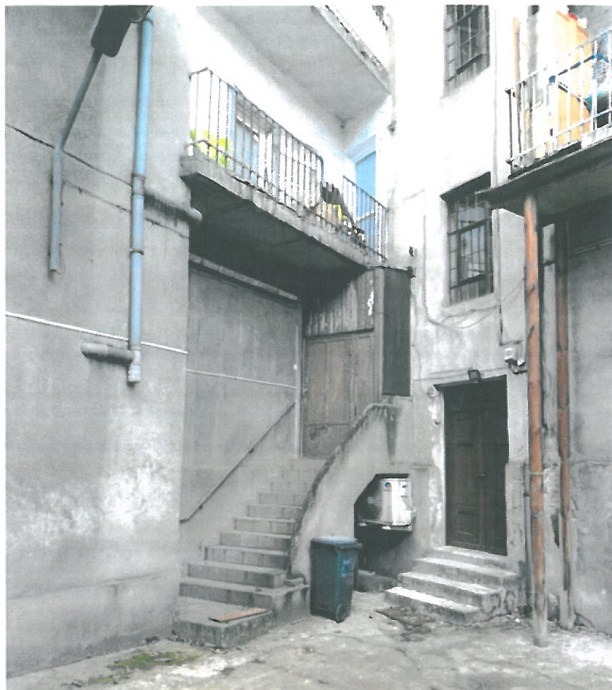
Fot. 6 Elewacja podwórzowa budynku mieszkalnego
