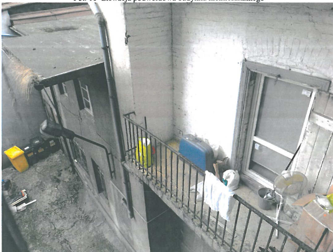
Fot. 11 Elewacja podwórzowa budynku niemieszkalnego – widok na połąć dachową, balkon budynku mieszkalnego
