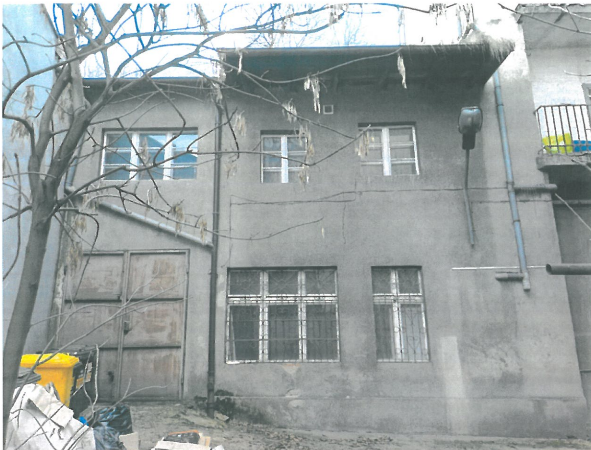
Fot. 10 Elewacja podwórzowa budynku niemieszkalnego
