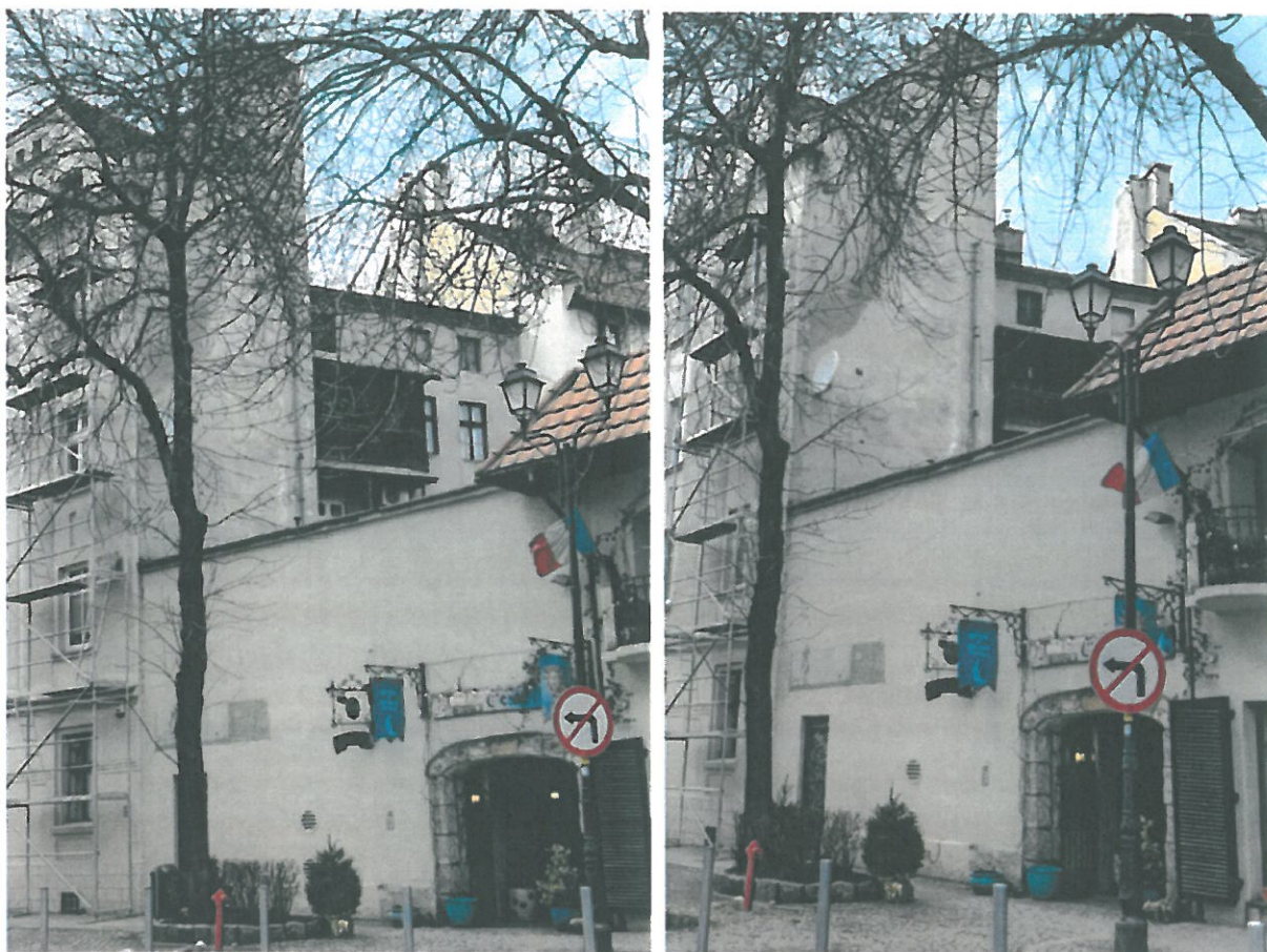
Fot. 1,2 Elewacja od strony ul. Ligonja, elewacja podwórzowa /fragment/
